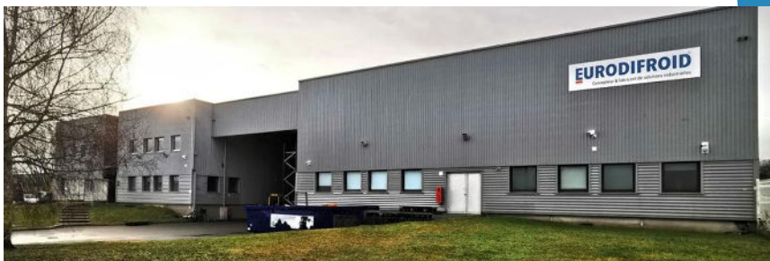
Eurodifroid s'est installé fin 2023 dans une nouvelle usine de 3.200 mètres carrés. (Eurodifroid)
