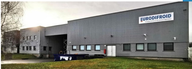
Eurodifroid s'est installé fin 2023 dans une nouvelle usine de 3.200 mètres carrés.
