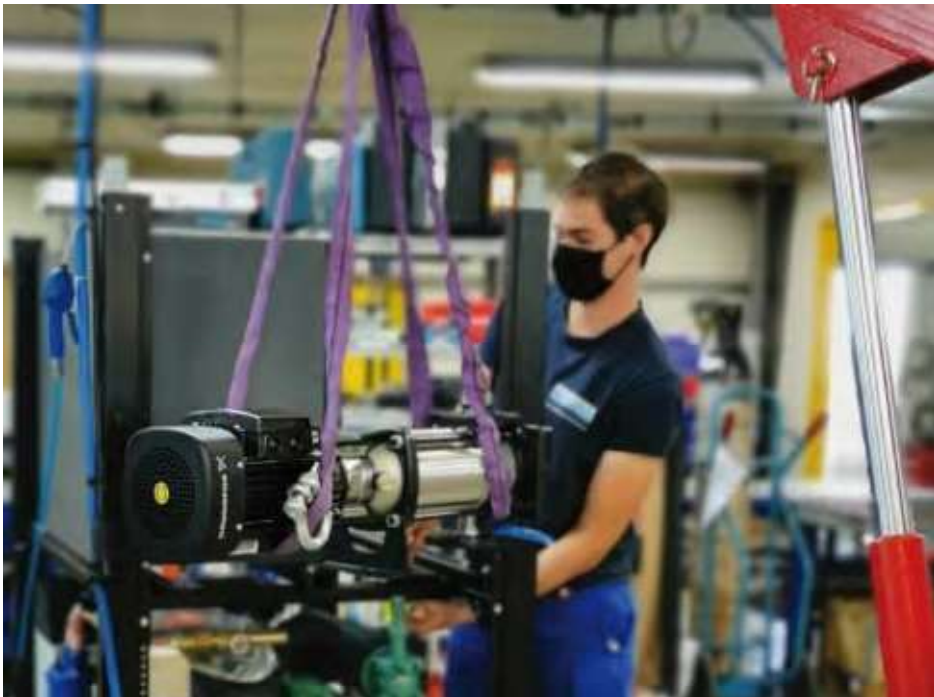
Construction d'un refroidisseur -40°C très compact.
