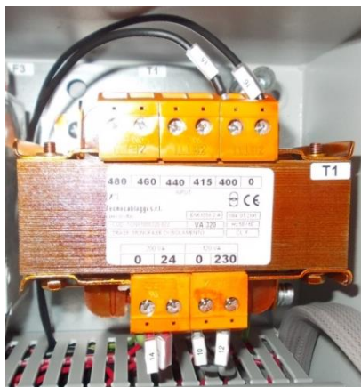
Branchement pour une alimentation 400V-3-50Hz
