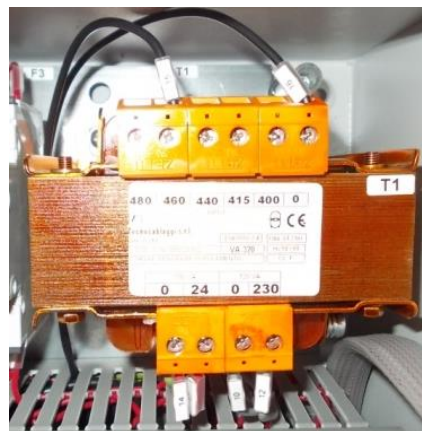
Branchement pour une alimentation 460V-3-60Hz
