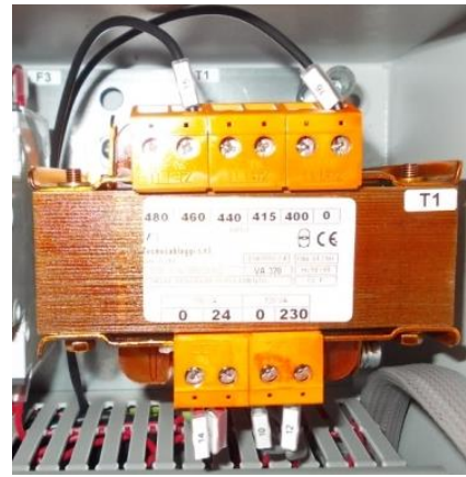
Branchement pour une alimentation 460V-3-60Hz
