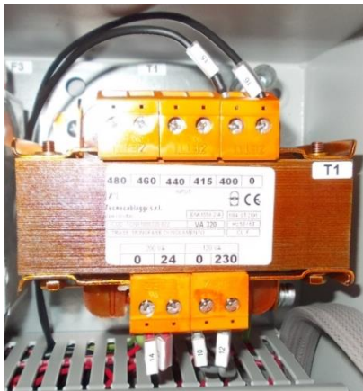
Branchement pour une alimentation 400V-3-50Hz
